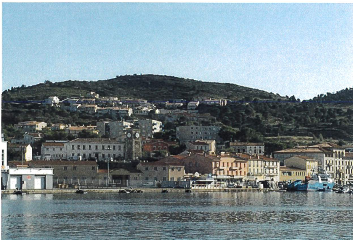
Avant : Etat des lieux du secteur du Pont de l'Amour, vue depuis le port de Port-Vendres
